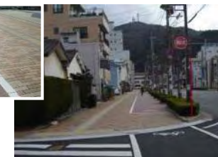
舗装材の違いにより走行空間の明確化を図った事例
