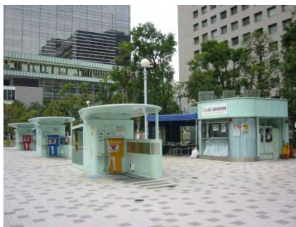
■ 駅前広場に機械式地下駐輪場を整備
