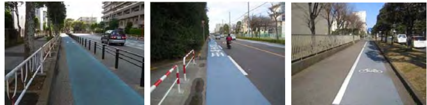
(自転車道) (自転車専用通行帯) (自転車通行位置の明示)
