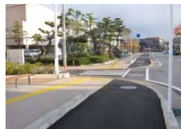
縁石で分離した自転車道
