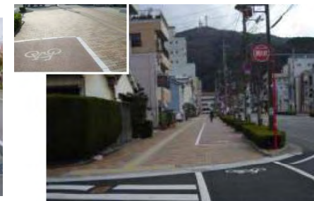
舗装材の違いにより 自転車の通行位置を明示
