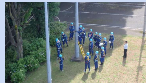
模擬無線鉄塔上での高所作業実習
