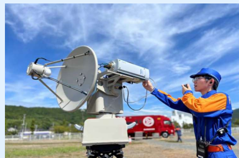
ヘリコプターテレビ用可搬自動追尾受信設備の立ち上げ訓練
