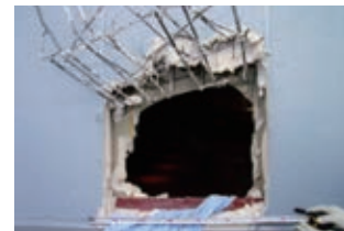
外壁に開けられた侵入用の穴
