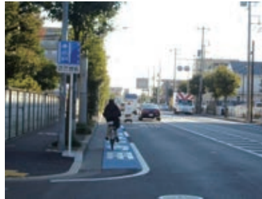
自転車専用通行帯の設置例（神奈川県横浜市）
