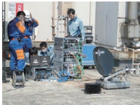
臨時に通信機器を設置する機動警察通信隊員
