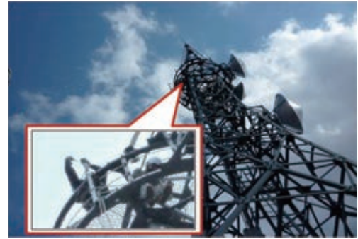
無線中継所に設置した代替用アンテナ
