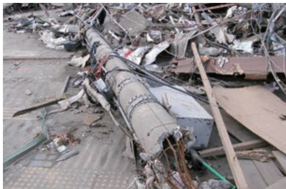
倒壊した信号機
