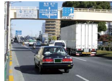
大型貨物車等の中央寄り車線規制
