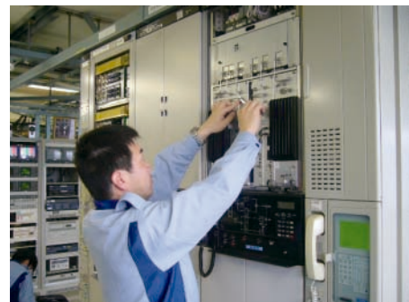
警察通信施設の点検の様子
