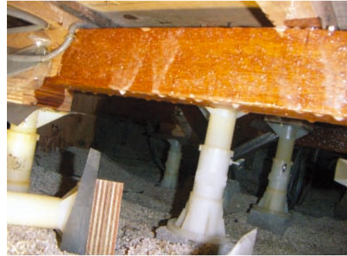
床下の不要な補強工事
