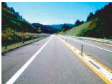
減速レーンマーク（施工前）
