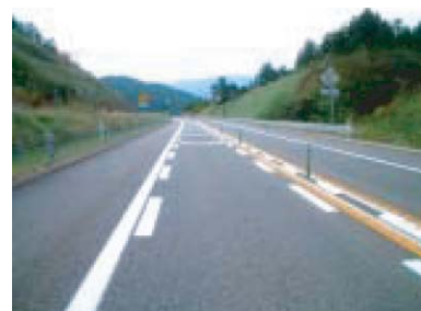
減速レーンマーク（施工後）
