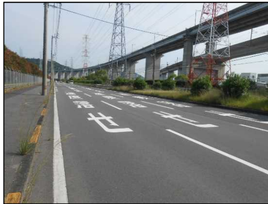
「速度落せ」の法定外表示
