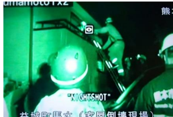
写真 5-7-1 倒壊建物への進入状況
