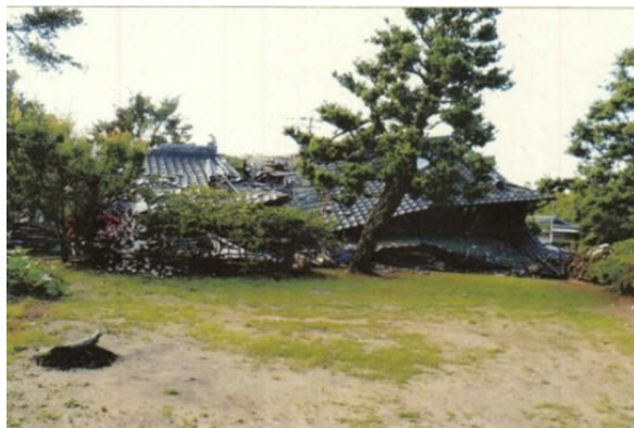
写真 5-10-1 建物倒壊状況 (提供: 現場関係者)
