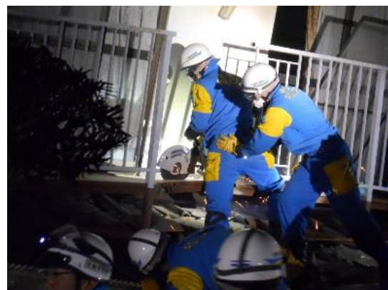
写真 5-12-2 進入箇所付近での破壊作業の状況
