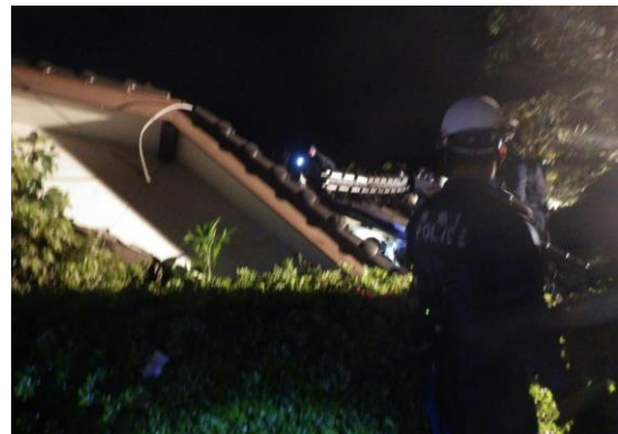
写真 5-6-1 現場到着時の状況
