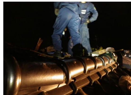
写真 5-6-2 進入箇所付近の状況
