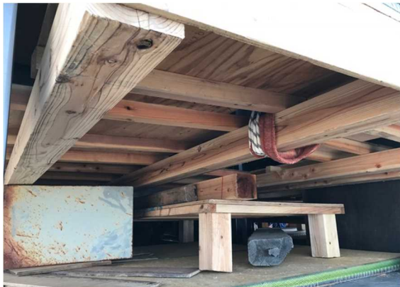
写真 4-2 閉じ込め空間の状況（訓練ユニット内部）
