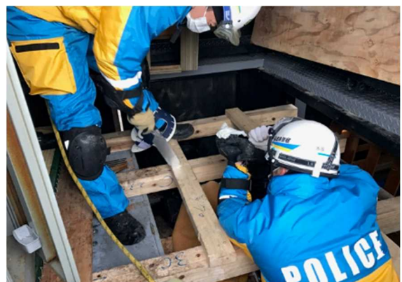
写真 4-5 床面破壊排除作業の状況
