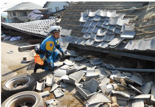
写真 3-3-31 被害確認作業の状況
