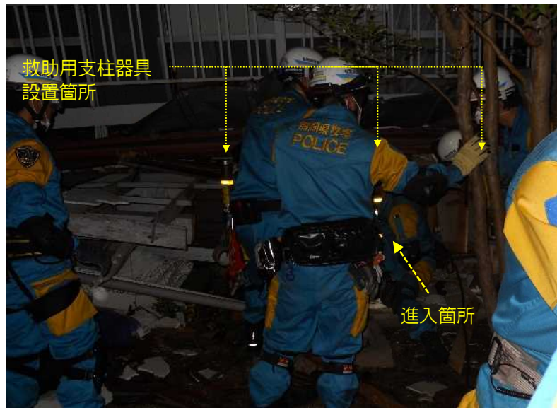
写真 2-2-4 救助用支柱器具の設置状況
