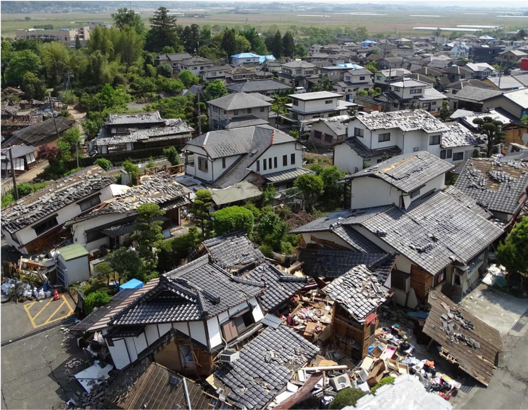
写真 1-1-1 益城町の建物倒壊状況
