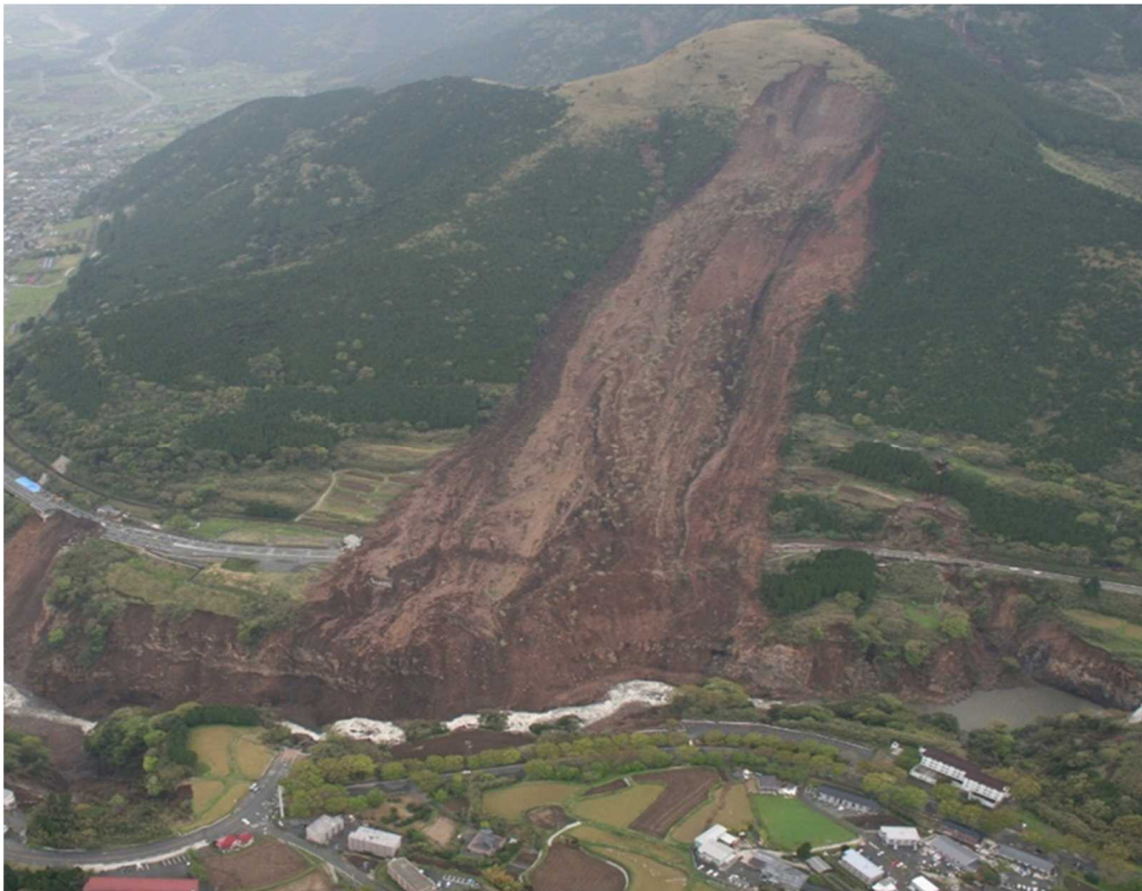
写真 1-1-2 南阿蘇村の土砂災害発生状況
