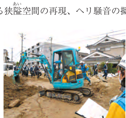
重機の出動状況
