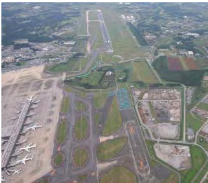
成田国際空港暫定平行滑走路（空港南側から撮影）
